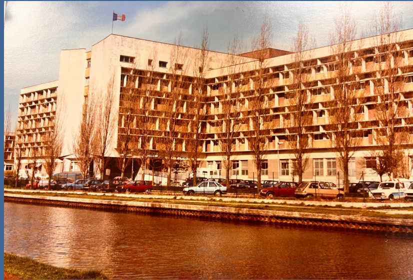
Figure 20: Photo de l'hôpital Jean Verdier, issue des archives de la mairie de Bondy, 1988
