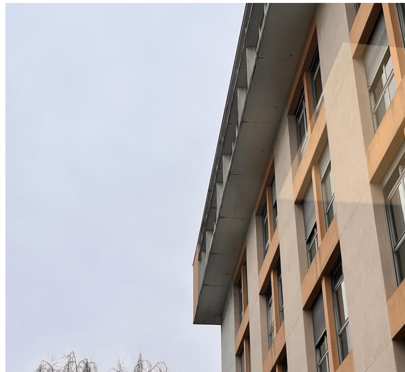
Figure 41: Photo de la facade ouest du batimet 200
