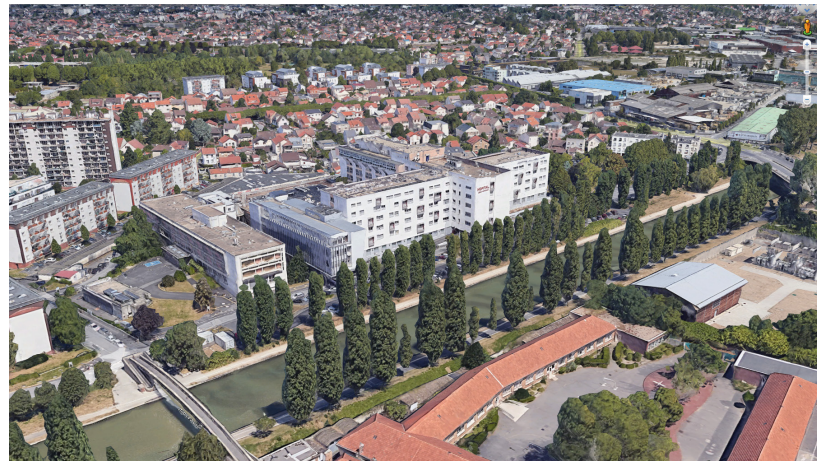
Figure 35: Image aérienne de l'hôpital Jean Verdier issue de Google earth
