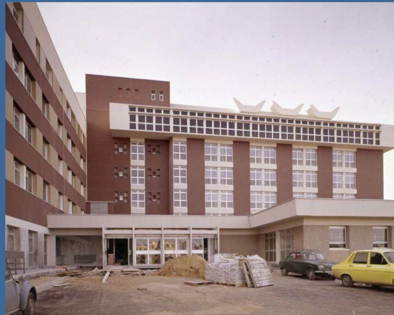
Figure 42: Photo de la facade est du batimet 200, 1973, issu des archives de l'APHP
