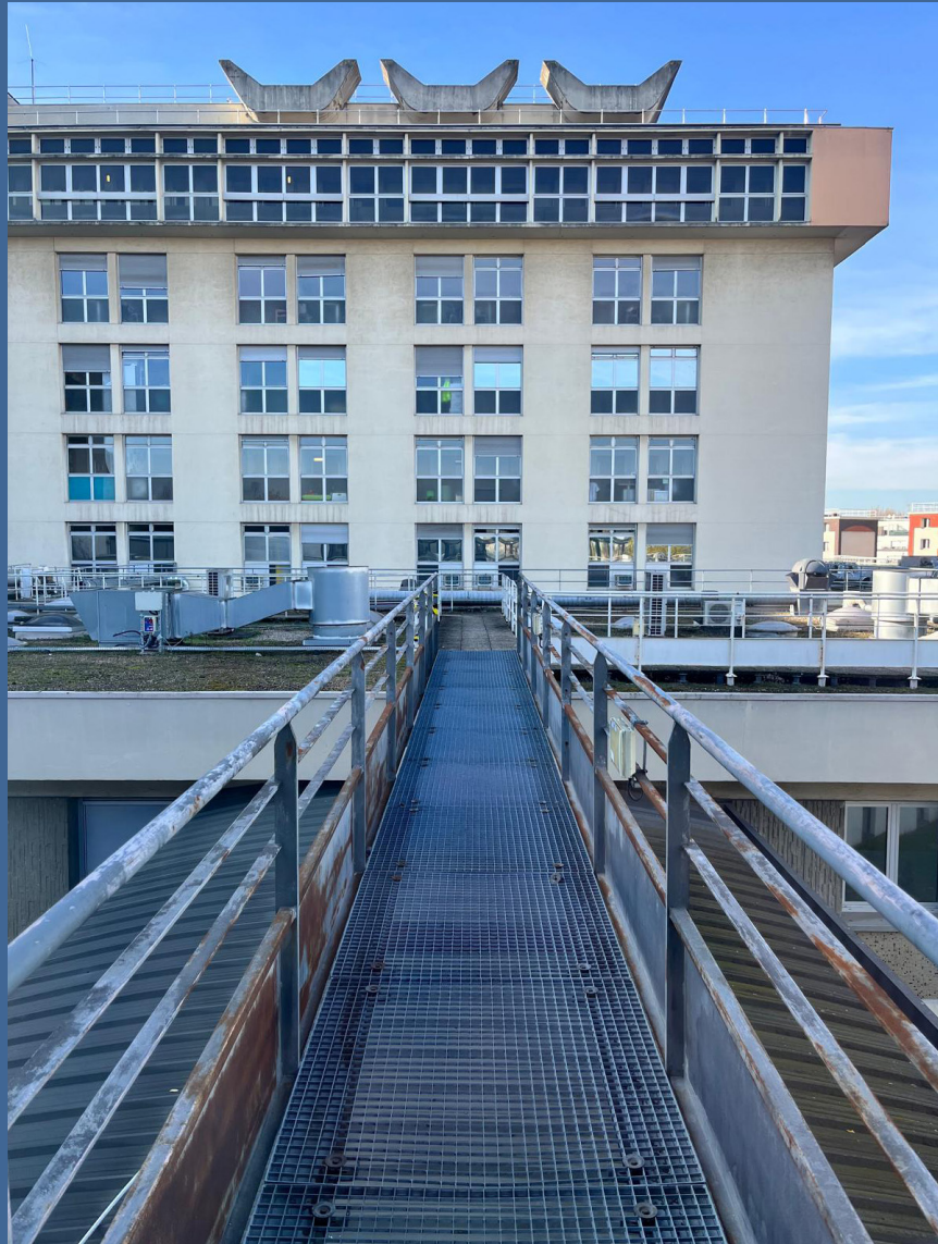
Figure 43: Photo de la facade est actuelle du batiment 200
