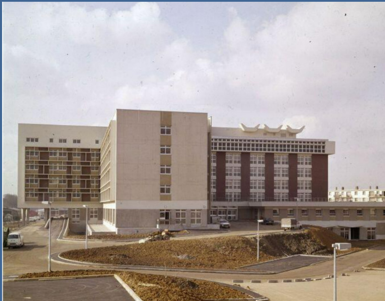
Photo de la facade est du batimet 200 pendant la construction, 1973, issu des archives de l'APHP
