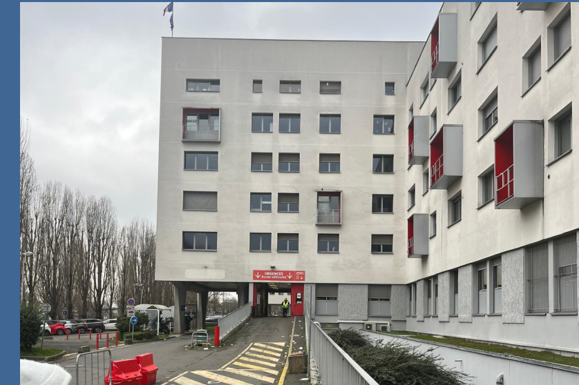
Figure 23: Photo actuelle de l'hôpital Jean Verdier
