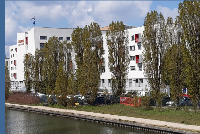
Figure 22: Photo actuelle de l'hôpital Jean Verdier
