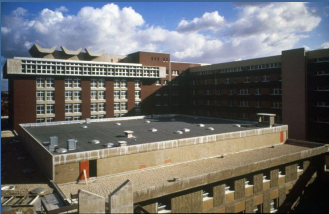
Figure 60: Photo de la facade ouest du batimet 200 pendant la construction, 1973, issu des archives de l'APHP
