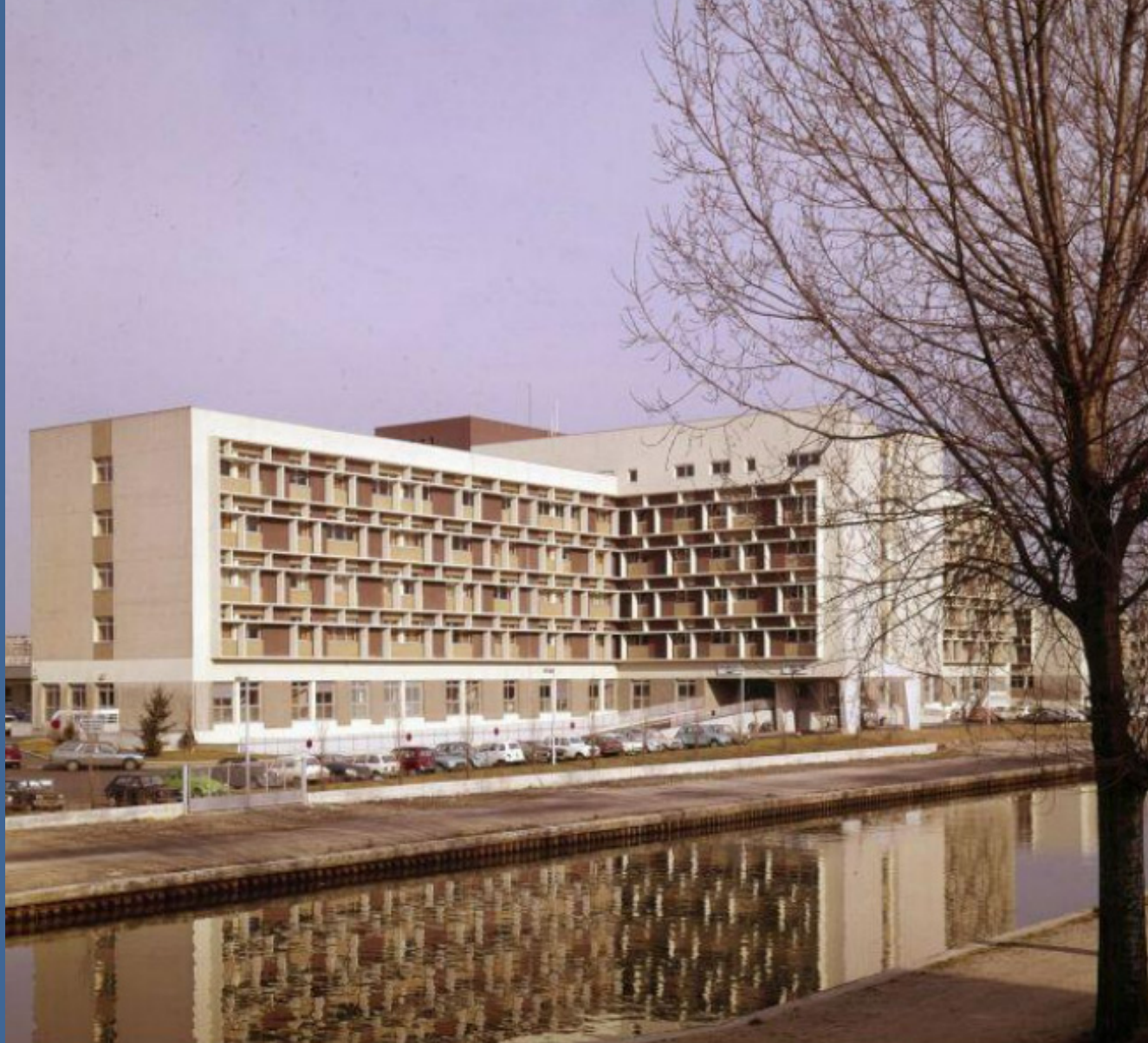
Figure 2: Photo de chantier de l'hôpital Jean Verdier, issue des archives de l'APHP , Bondy 1973
