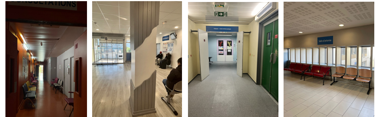
Photos de l'hôpital démontrant la multitude de matériaux et de couleurs dans le bâtiment
