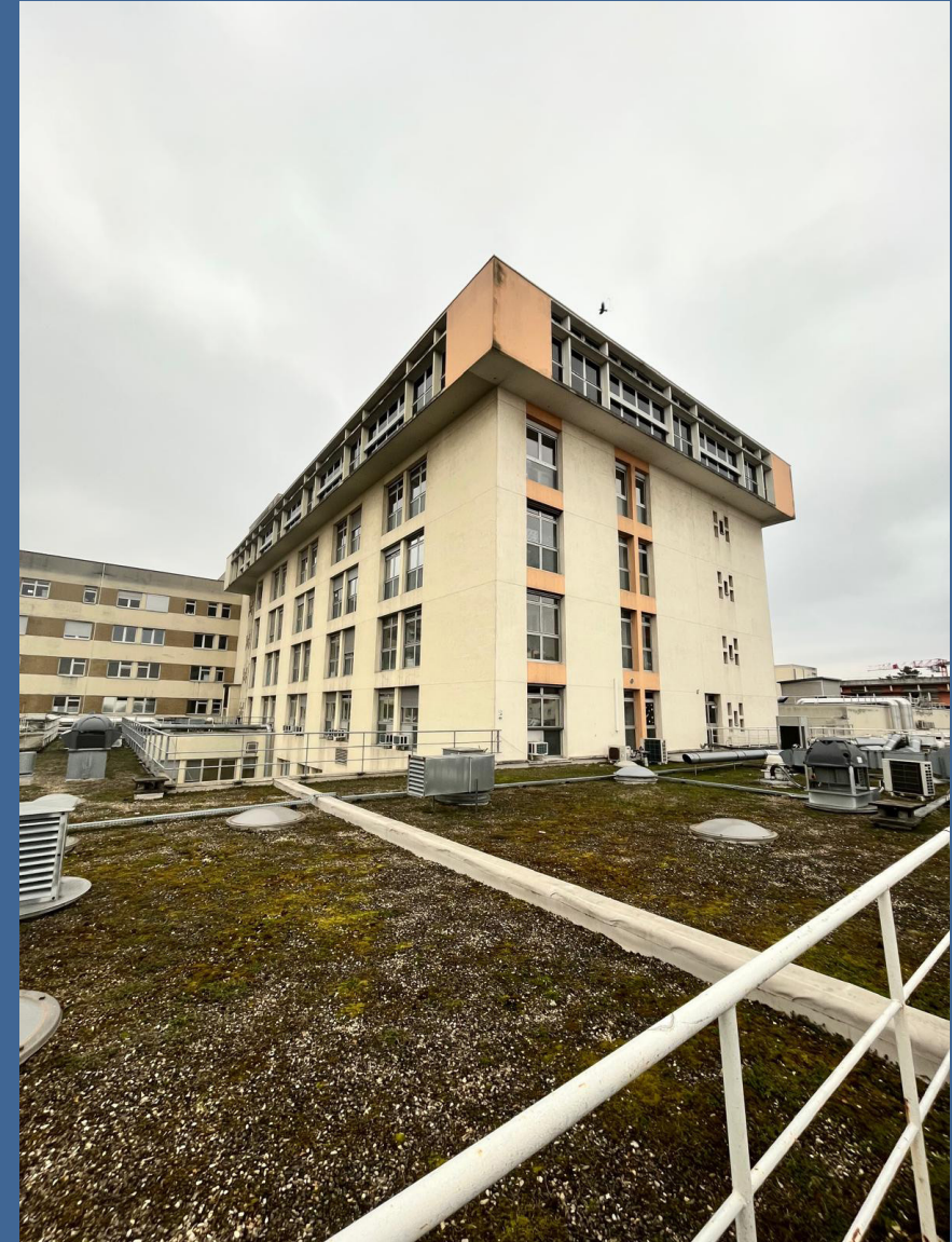
Figure 44: Photo de la facade nord est actuelle du batiment 20
