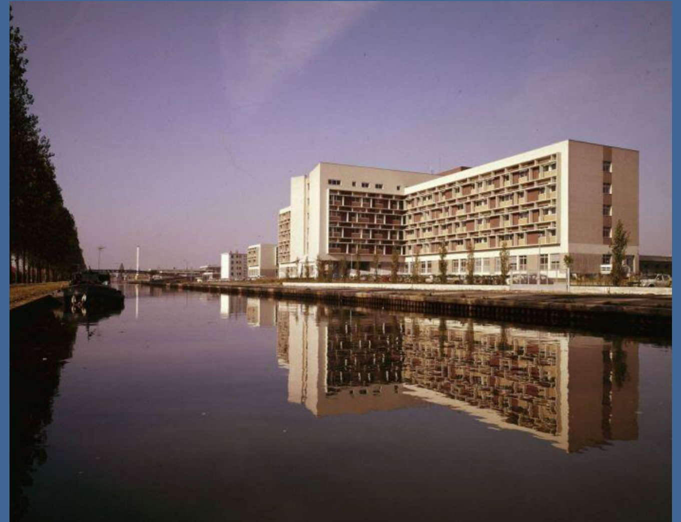
Figure 1: Photo de chantier de l'hôpital Jean Verdier, issue des archives de l'APHP, Bondy 1973
