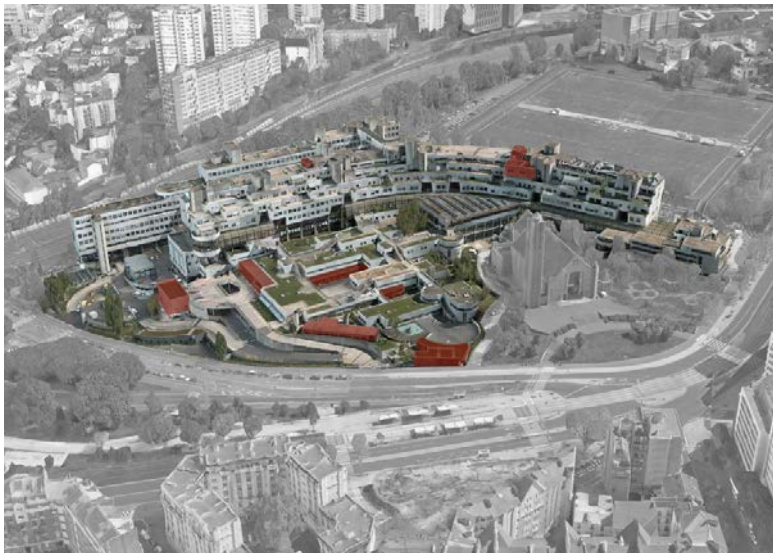
Figure 46 : Axonométrie de l'hôpital Robert- Debré, vue sur extensions en rouge, © Yin LE SEIGNOUX, Image de fond : © 2023 Google 2023 Google
