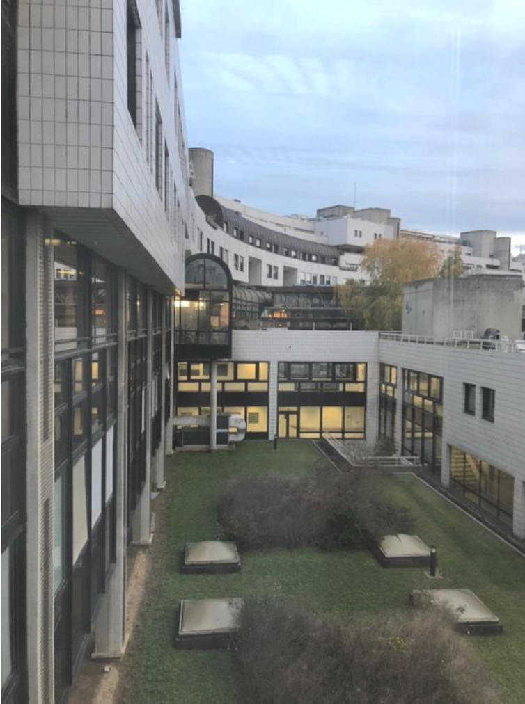
Figure 54 : Matérialité extérieure de l'hôpital Robert- Debré, Octobre 2022, © Yin LE SEIGNOUX
