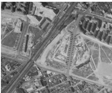
1955 - début du terrassement
