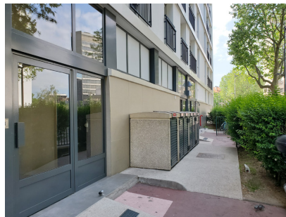
Fig 55. Cem Karahan AYDIN, (2022), Photo de l'entrée du bâtiment B1 (à gauche)
