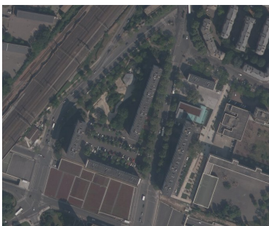
2011 - couverture partielle du périphérique
