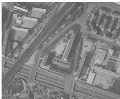
1966 - construction du périphérique
