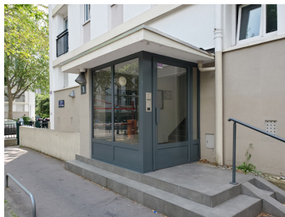
Fig 53. Cem Karahan AYDIN, (2022), Photo de l'entrée du bâtiment A2 (à gauche)
