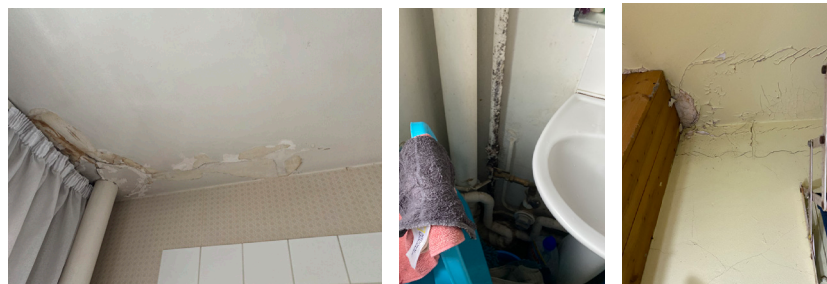
Fig 73. Cem Karahan AYDIN, (2022), Série de photos témoignant de pathologies dû à la condensation
