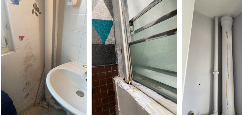
Fig 70. Cem Karahan AYDIN, (2022), Série de photos témoignant de pathologies dû aux infiltrations
