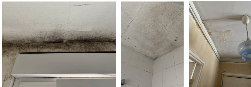
Fig 71. Cem Karahan AYDIN, (2022), Série de photos témoignant de pathologies dû à l'humidité
